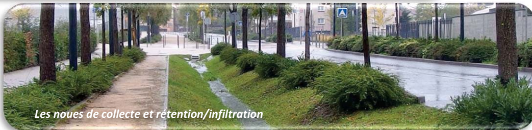
Bassin de rétention enterré en génie civil
