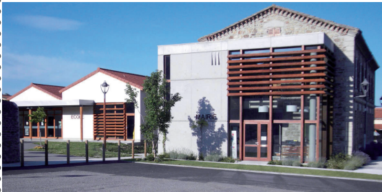
Exemple de lames orientées fixes
