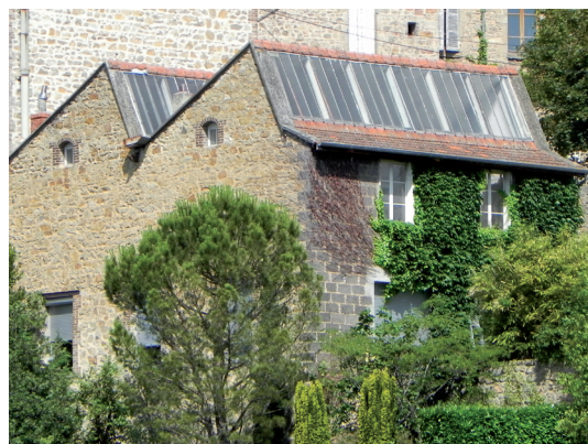
Exemple de toiture en Shed
