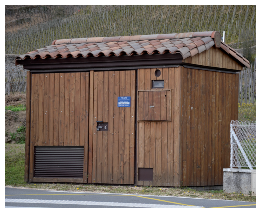
Exemple de traitement d'un transformateur électrique à privilégier
