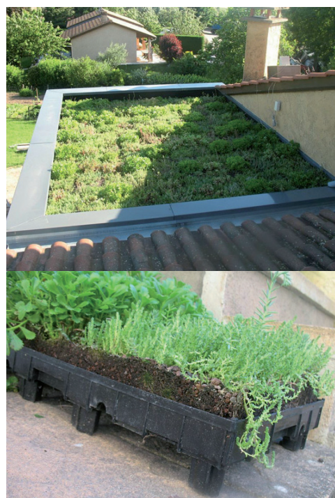
Exemple de toiture-terrasse végétalisée et bacs pré-cultivés
