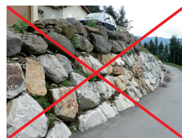
Exemple d'enrochements de type cyclopéen
