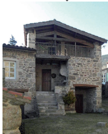
Exemple de débord de toiture
