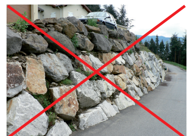
Exemple d'enrochements de type cyclopéen
