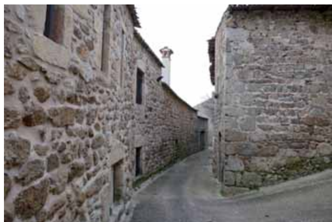
Le bâti dans le bourg est aligné en R+1 autour de ruelles étroites
