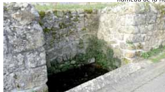
Serve insérée dans un mur de soutènement en pierre dans le hameau de la Ratte
