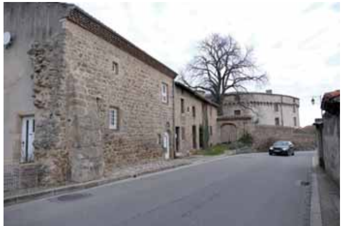
Absence de trottoir et forte circulation sur la RD 503 aux abords du château
