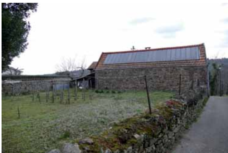
Ancien atelier transformé en habitation à la Pilaterie
