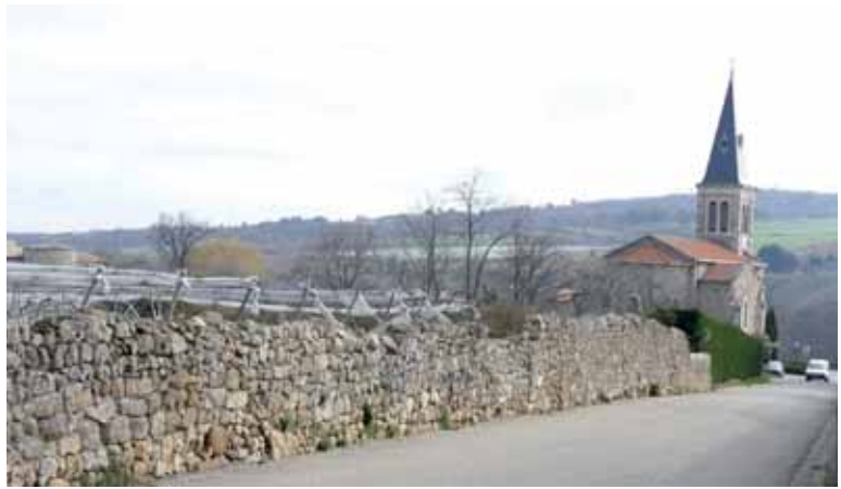
Long mur en pierre bordant un grand verger à l'entrée nord du bourg
